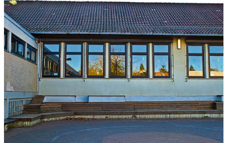
Energie und damit Kosten sparen will die Verbandsgemeinde an der Grundschule Stromberg. Die Gebäude sollen energetisch saniert werden. Offen ist allerdings, ob die Baumaßnahme noch in diesem Sommer über die Bühne gehen kann. Foto: Wolfgang Bartels
